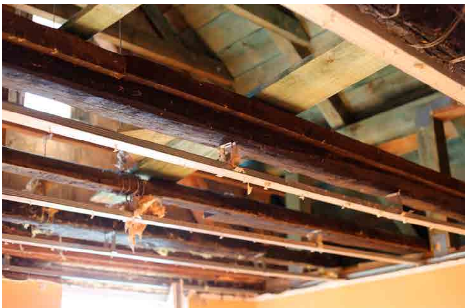
Dach był kompletnie zerwany, tutaj już po naprawie.
